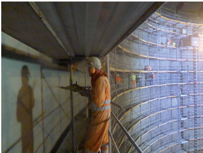
Bild 1 Auftragen einer Feinbetonschicht mittels Spritzverfahren
